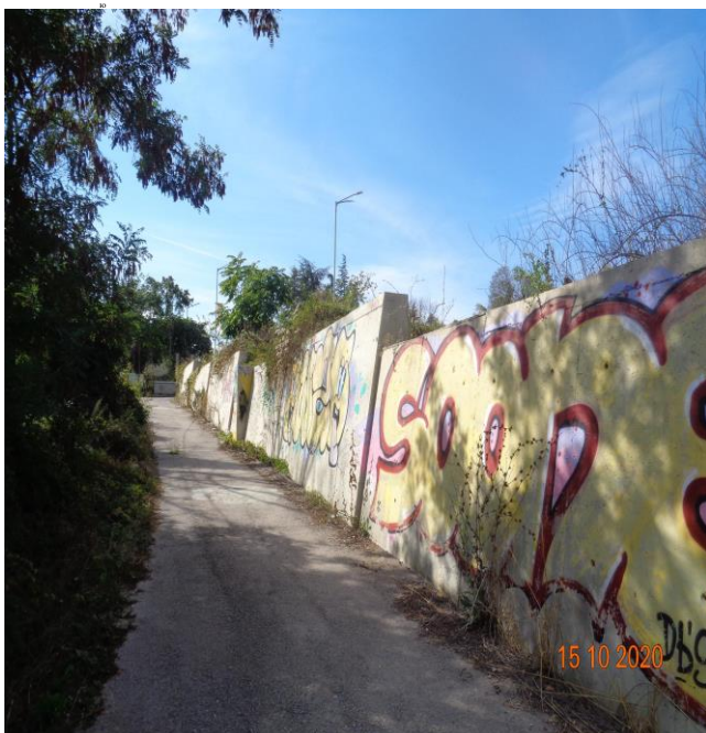
подпорна стена и ростверк на пилотна конструкция под път I-9
