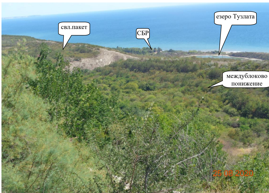
общ изглед в района на свлачището
