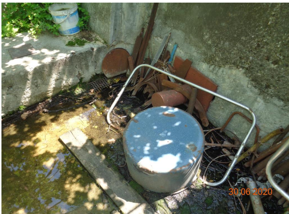
сн.4,5 – заблатяване по пилотно-анкерната конструкция в имота „Овеч“ 10
