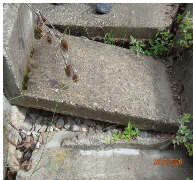
локални деформации по охранителните канали
