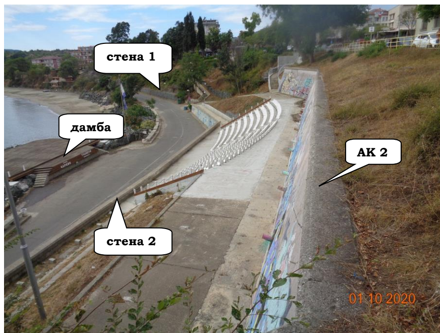
общ изглед АК2, подпорна стена 2а и брегоукрепителна дамба
