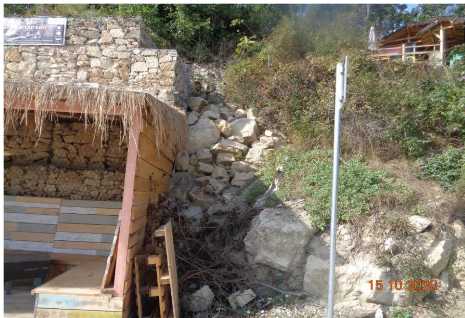
северен край на стената от габioni и неукрепеното свлачище VAR 06.10135-05-10 в съседство
