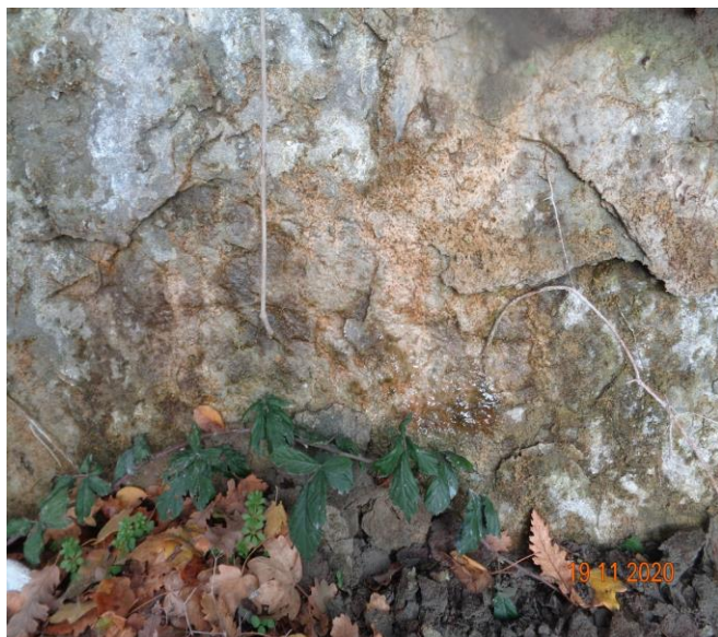
дрениране на вода в пясъчник по откоса
