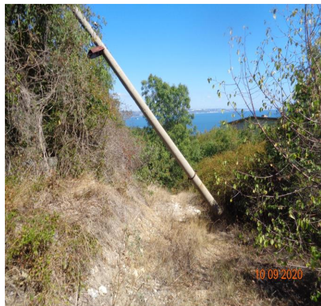
наклонен ел.стълб
