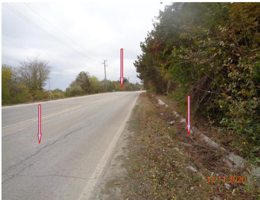
пукнатини по пътя (на преден план) и подуване на пътя (в далечината)
