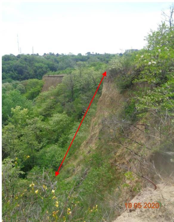
2020 г. – свлачищен отстъп
