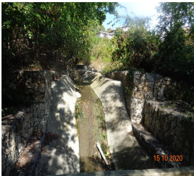
корекция на дере „Траката“ и заустване на води от изтичалото на площадка 8.2 в дерето
