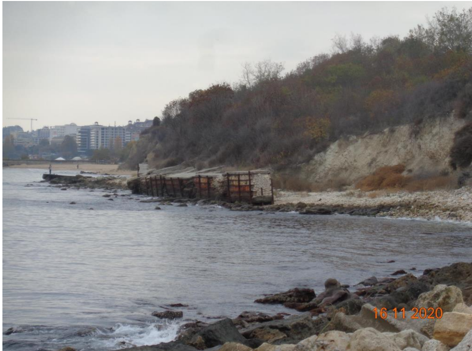
2020 г. - брегозащитната стена
