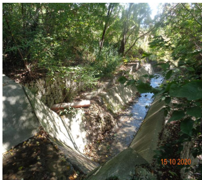
корекция на дере „Траката“ и заустване на води от изтичалото на площадка 8.2 в дерето
