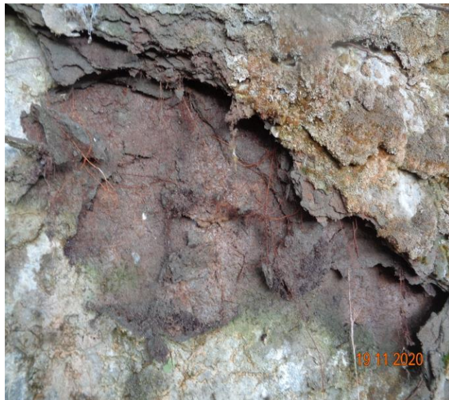
дрениране на вода в пясъчник по откоса
