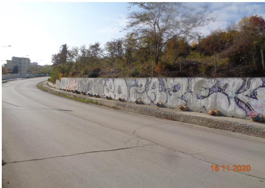
пилотно-анкерната конструкция и пукнатини по пътните платна
