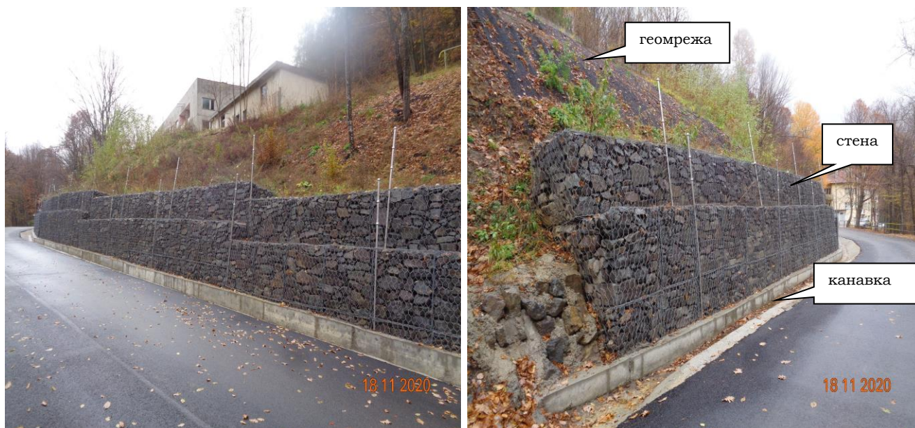
общ изглед-стена от габioni, облицована канавка и геомрежа
