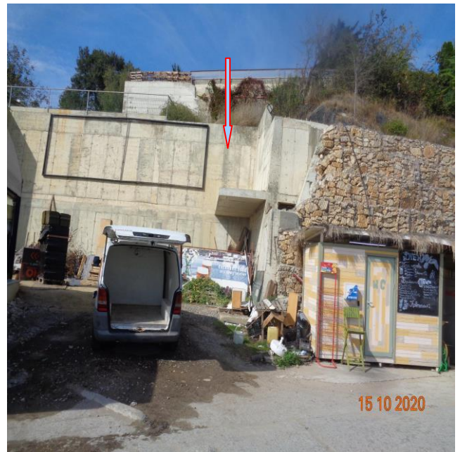
стена от габioni пред свлачище VAR 06.10135-05-11 и стена от бетон, изградена в съседен имот
