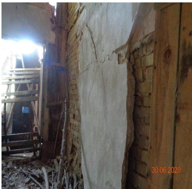
сн.9,10 – нарушения в сутерена /ляво/ и по гаражите видни нарушения по първи етаж - отвън /ляво/ и вътре
