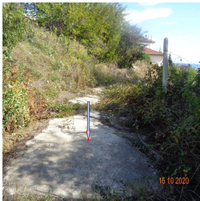
ростверк на конструкцията при северния вход на подзеца
