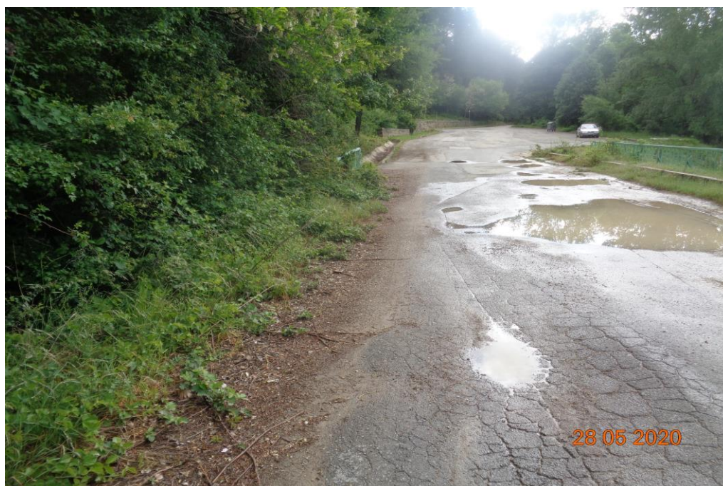
хлътване на настилката на пътя и задържане на вода
