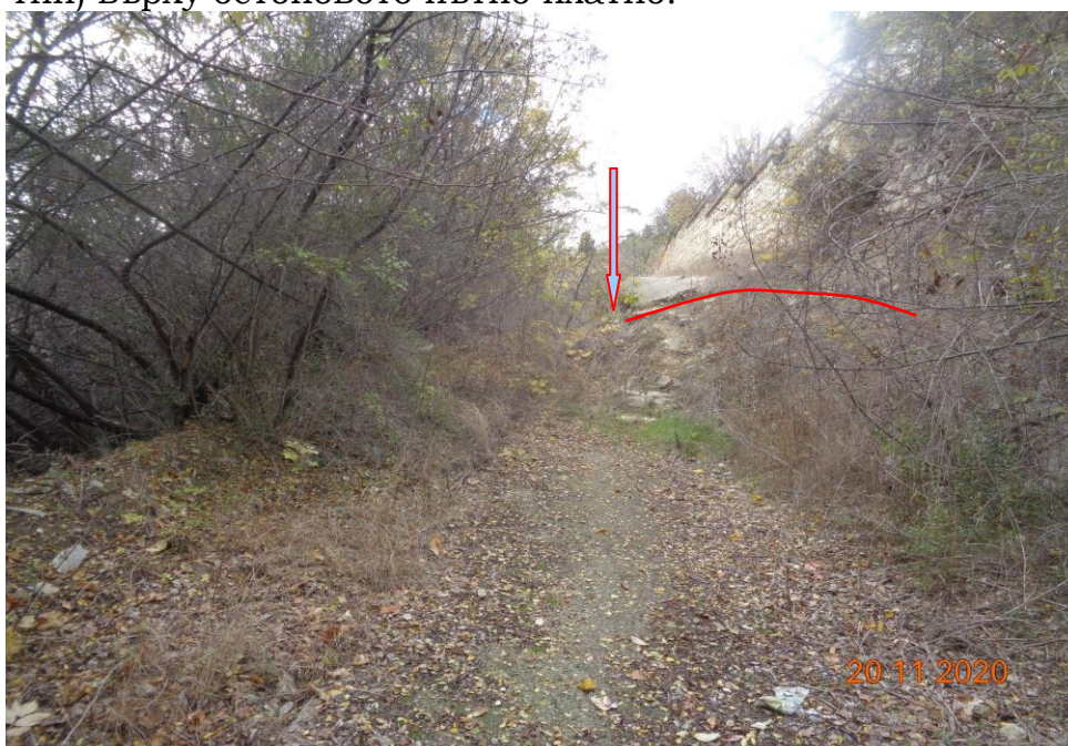
пресичането на обслужващия път от отстъпа на свлачище 6 и нарастналото денивелирание на пътя
