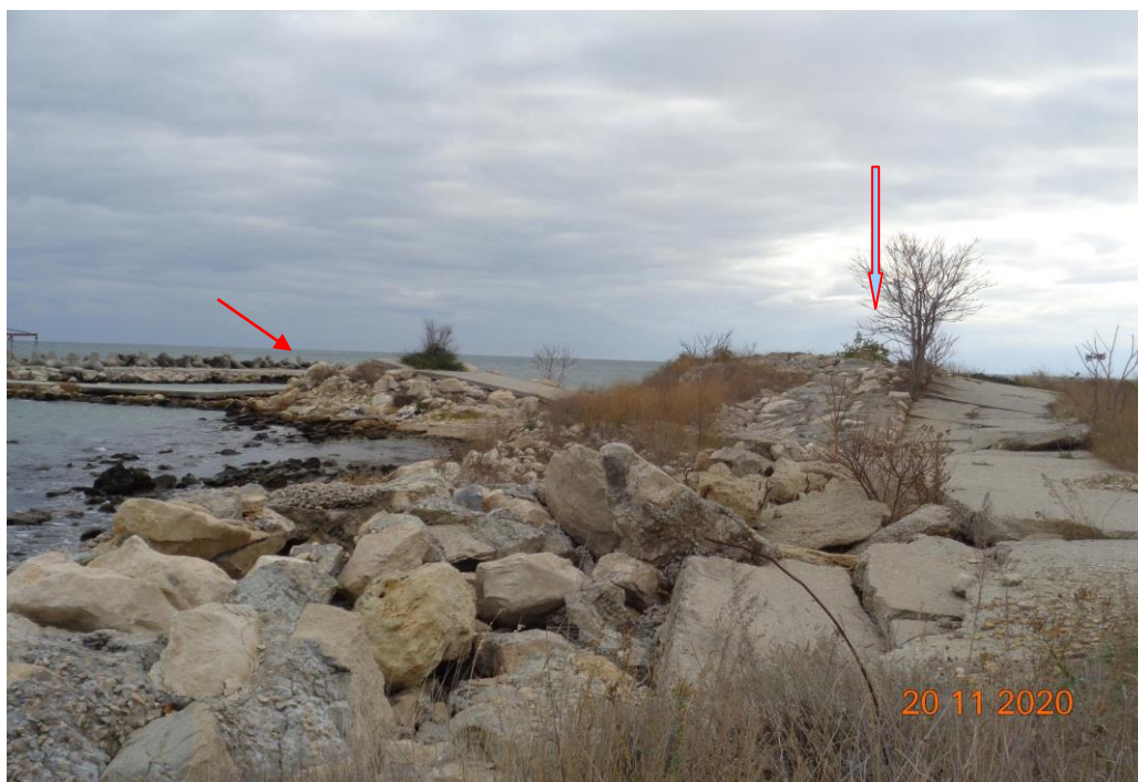
издигнатия и разрушен траверс при вълнолом II
