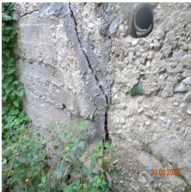
сн.8 – пукнатина по оградна стена
