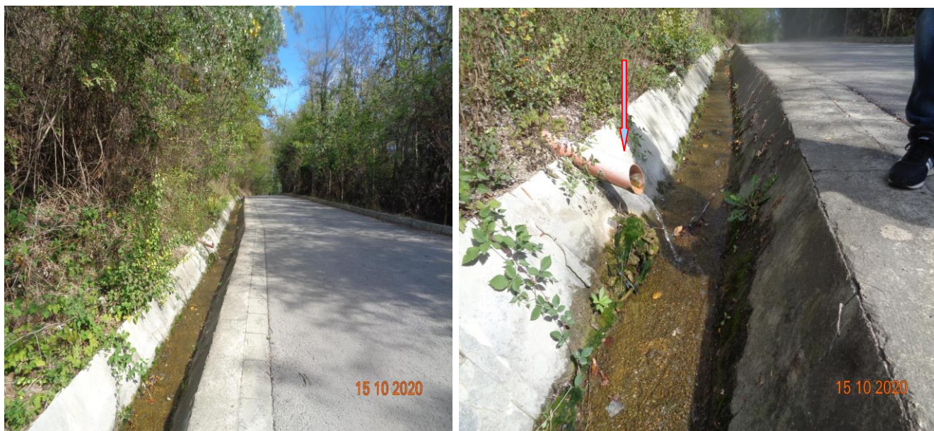
отводнителната канавка покрай пътя към Рибарското селище и изтичалото на ВШ-2
