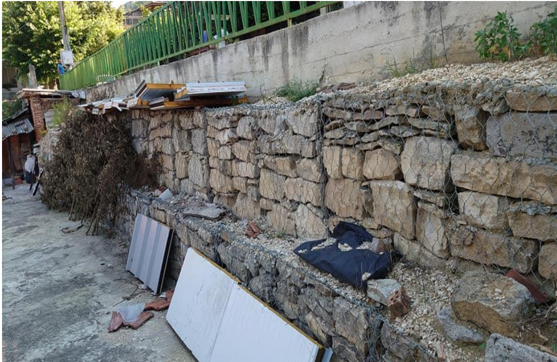
сн.1- 30.06.2020 г. - стената от габioni на ул.“Калипетровски“ №№ 14,16,18
