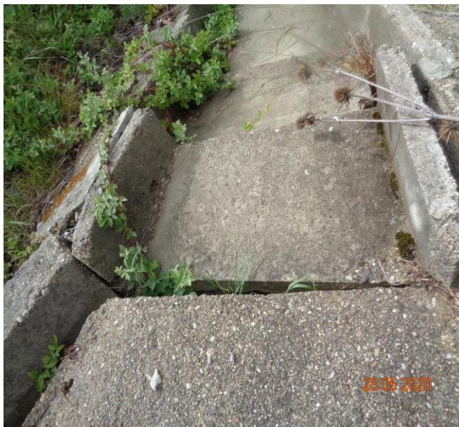
локални деформации по охранителните канали
