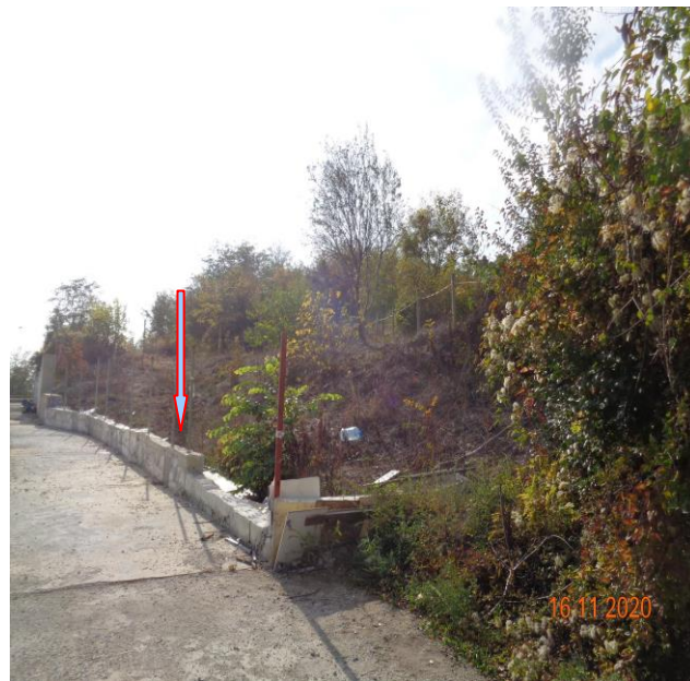
зидана от собственик стена върху ростверка на пилотно-анкерната конструкция
