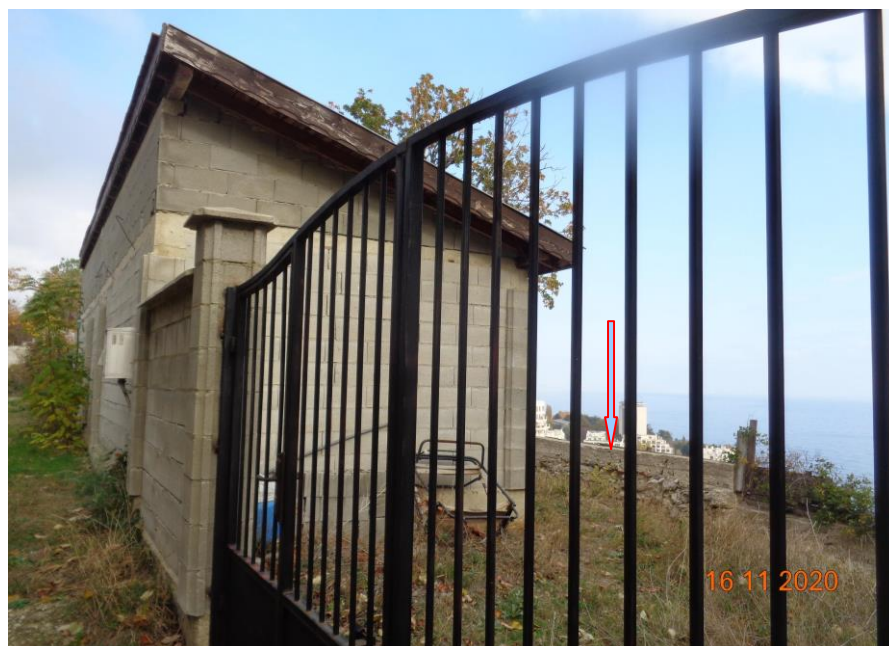
застрояване на ръба на свлачищния отстъп
