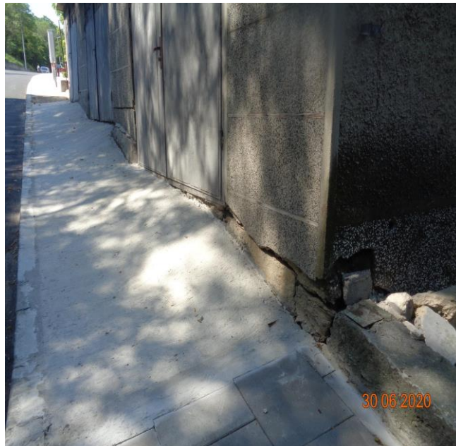
сн.9,10 – нарушения в сутерена /ляво/ и по гаражите видни нарушения по първи етаж - отвън /ляво/ и вътре
