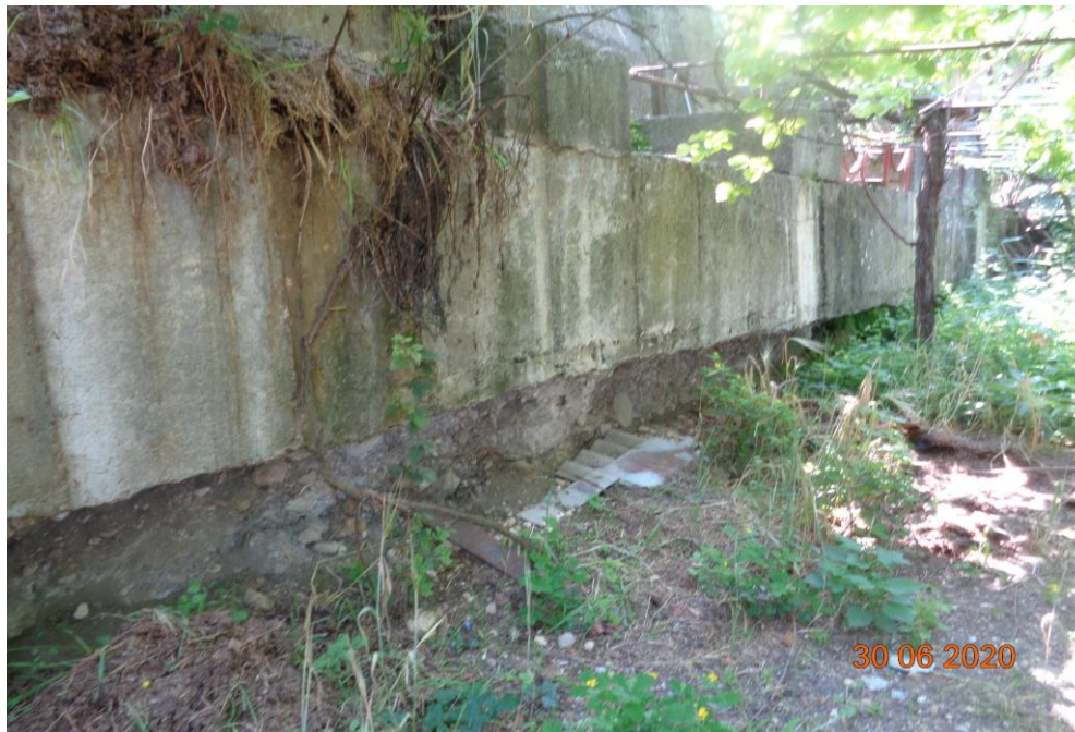
сн.3 – оголване основата на ростверка
