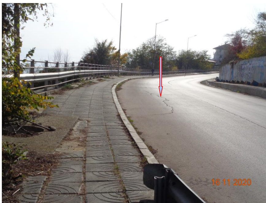
пукнатини по източното пътнo платно и крайпътна шахта без капак
