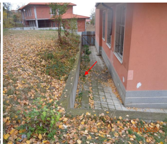
в основата на подпорната стена
