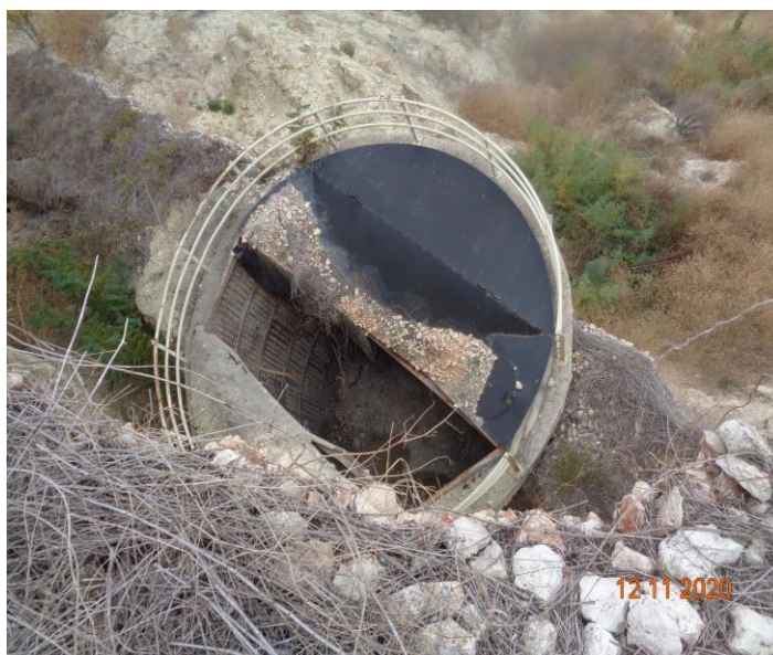
Шахта Ш7 - поглед отгоре
