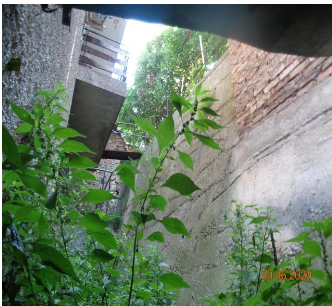
сн.6 - стената зад сградата на ул.“Скобелев“ 11
