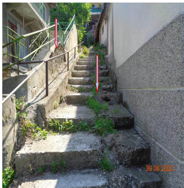
сн.9 – нарушения от теч на води
