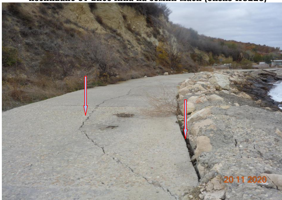
пукнатина и отделяне на заскалявката по дамбата
