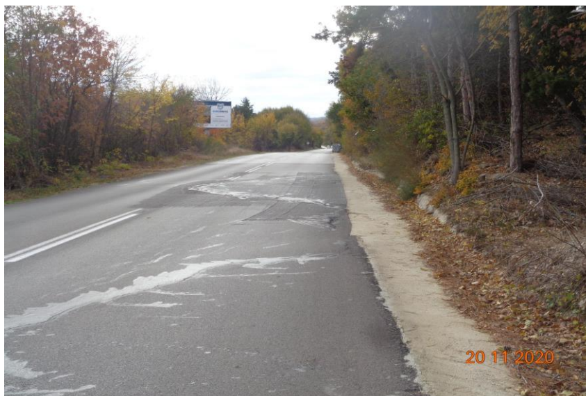
пукнатини в преасфалтиран участък по път I-9
